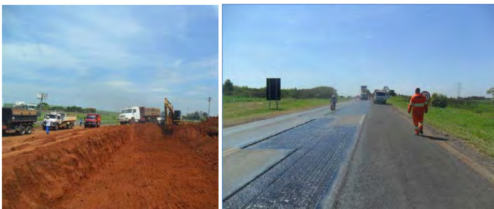
Fotografia 3 – Esquerda: Terraplenagem em na duplicação da SP-308. Direita: Andamento da pavimentação da duplicação da SP-308. Fonte: Relatório de andamento, dezembro de 2012
